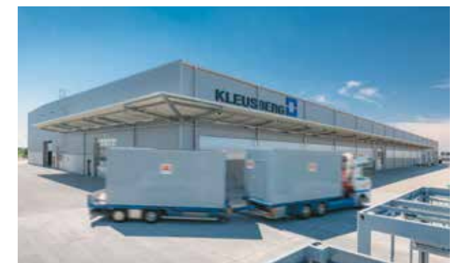
Termingerechte Auslieferung der Mieteinheiten
