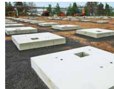
Fundamentierung mit Beton-Fertigteilplatten
