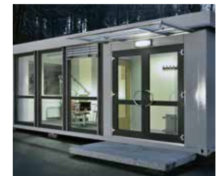
Eingang mit Vordach
