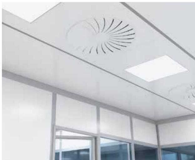
Eine RLT-Anlage, die über ein BUS-System angesteuert wird, regelt Temperatur, relative Luftfeuchte und Überdruck.
