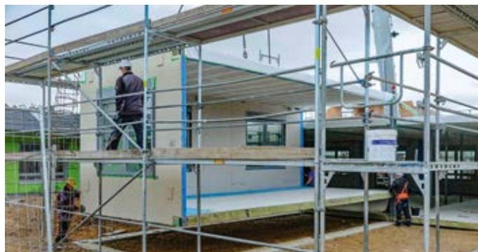
Ende Oktober rollten die Schwertransporter mit den insgesamt 11 Modulen in Roßdorf-Gundershausen an. Die bestehende Kindertagesstätte „Pirateninsel“, welche KLEUSBERG 2014 bereits in Modulbauweise realisiert hat, wird an der Südseite erweitert. Innerhalb von 2 Tagen konnte der Rohbau fertiggestellt und mit dem Innenausbau begonnen werden.
