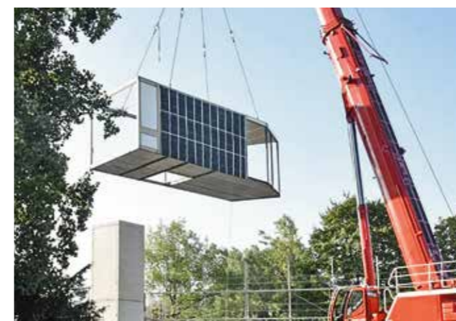
die Modulmontage erfolgte innerhalb von 9 Tagen
