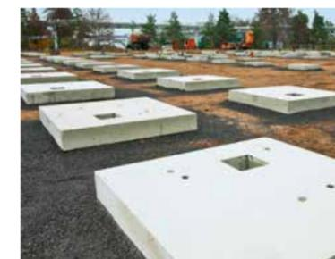
Fundamentierung mit Beton-Fertigteileplatten
