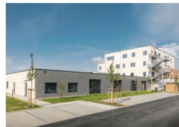
Behandlungsplätze im hinteren Gebäuderiegel.
