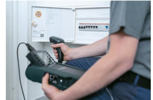
Die dokumentensichere Elektroprüfung im Werk gemäß VDE gewährleistet die Sicherheit und Funktionsfähigkeit der Anlagen.
