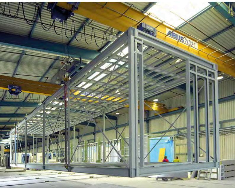
Transport der Module zum nächsten Produktionsschritt, dem Trockenausbau im Werk.
