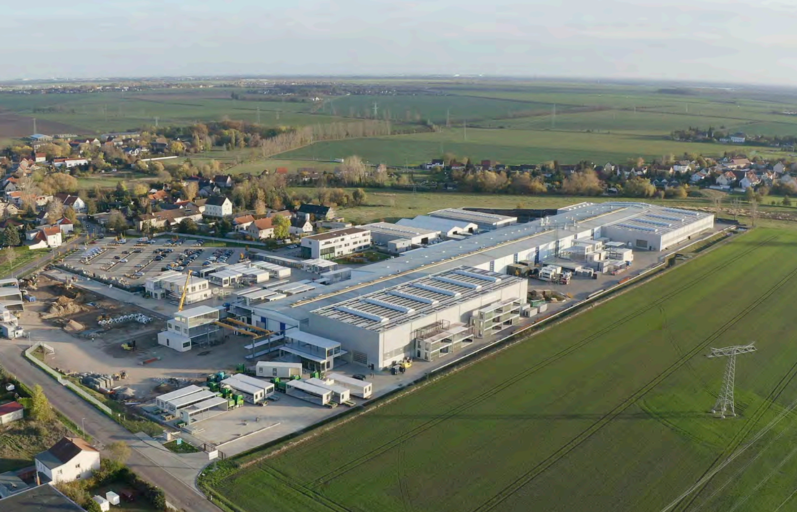
KLEUSBERG Werk 2 in Kabelsketal.
